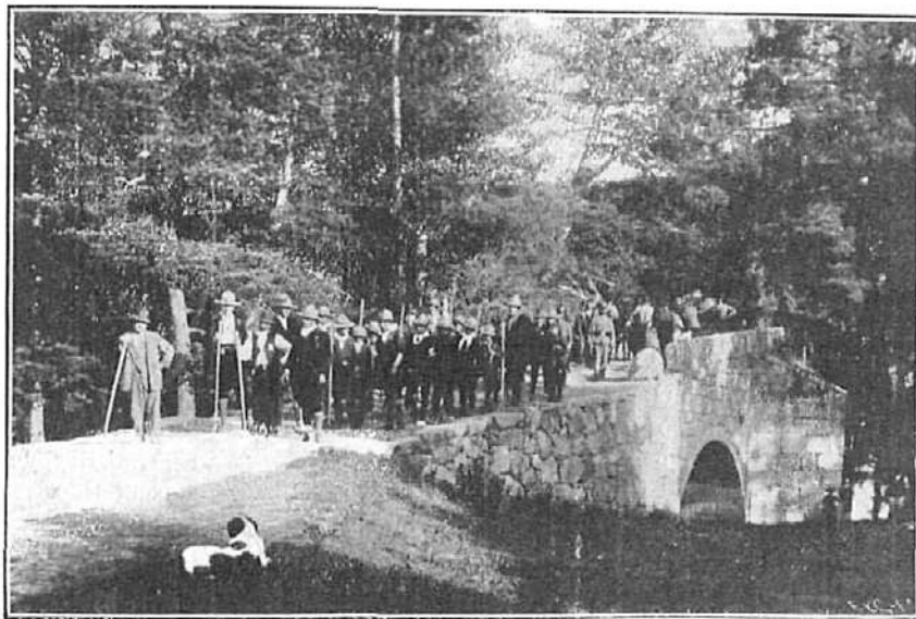
Los exploradores al pasar el puente del Duque.—Fot. de Vega Alberche.
